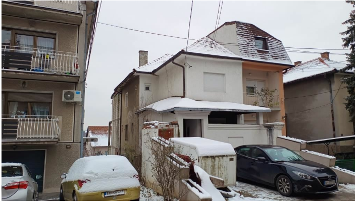
Pogled na zgradu
